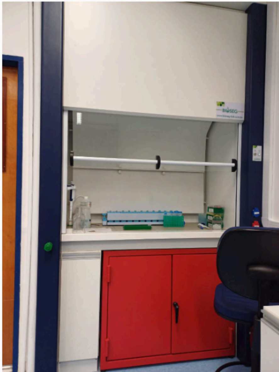
Instalação de capela de exaustão e armário corta-fogo
