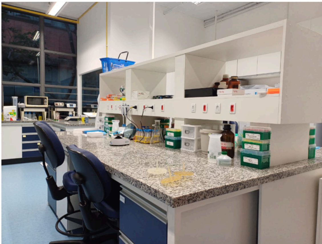
Instalação de novas bancadas
