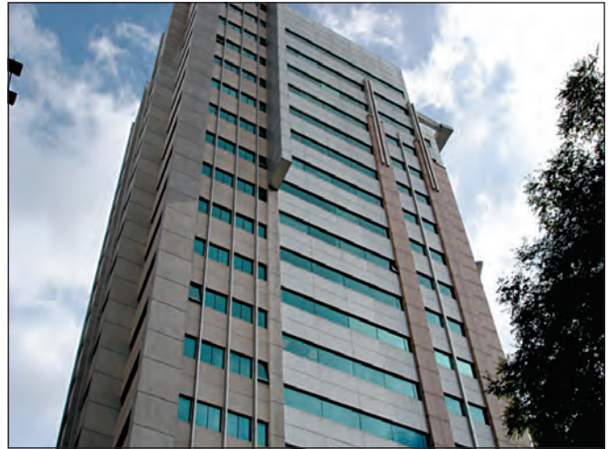
Figura 10: Compartimentação vertical de fachada
