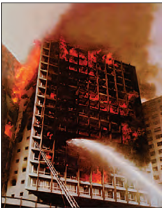
Figura 11: Incêndio no Edifício Andraus
