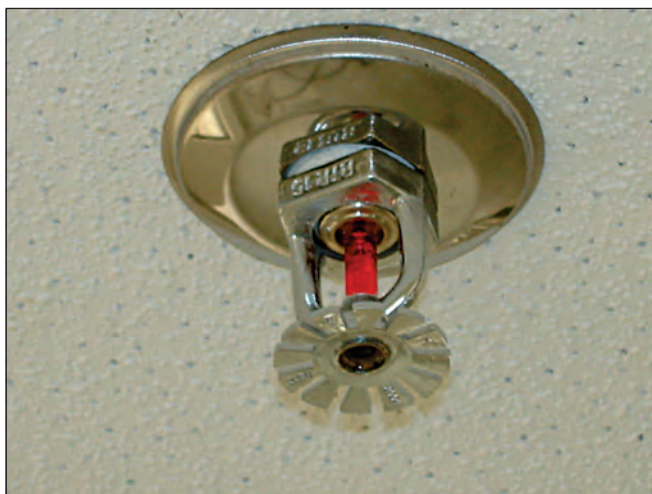
Figura 68: Chuveiro automático
