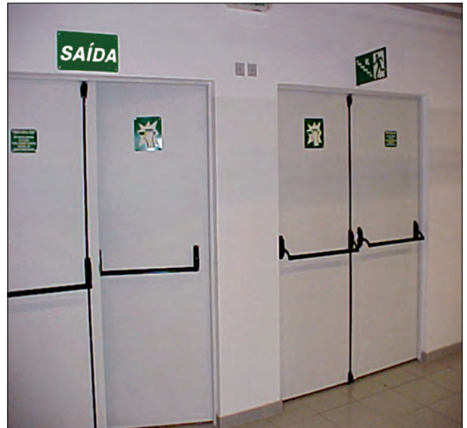
Figura 53: Porta com barra antipânico
