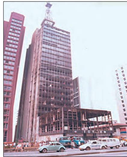
Figura 14: Incêndio no Edifício Grande Avenida
