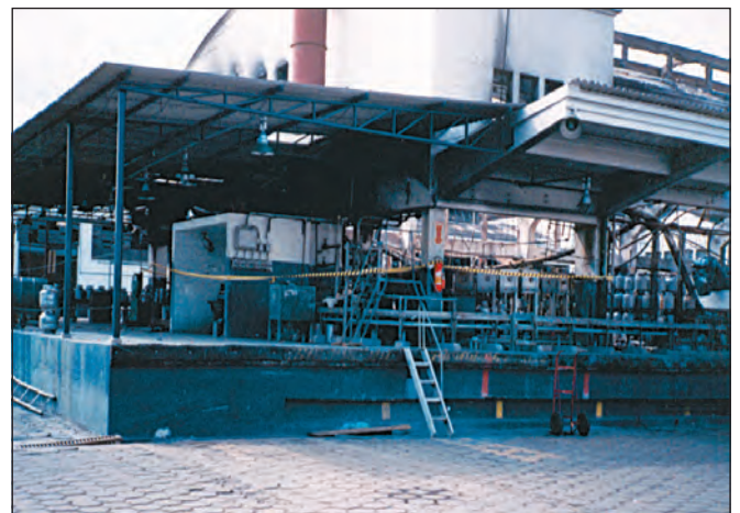
Figura 7: Isolamento do local sinistrado
